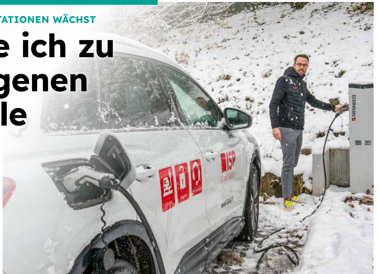
Philippe Burkhalter, ISP Electro Solutions AG, schliesst seinen Firmenwagen an die Ladesäule an.
